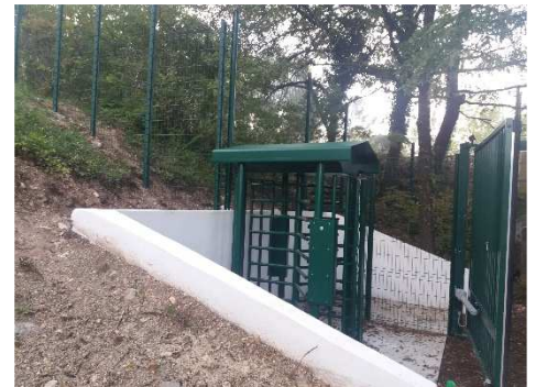
Lycée Valabre (Gardanne) Mise en sécurité accès
