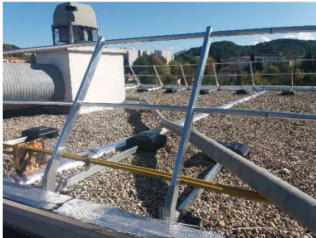
Lycée Cézanne (Aix en Provence) Réfection étanchéité & pose de garde-corps
