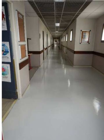
Lycée Saint Charles (Marseille) Réfection sol circulation & pose résine
